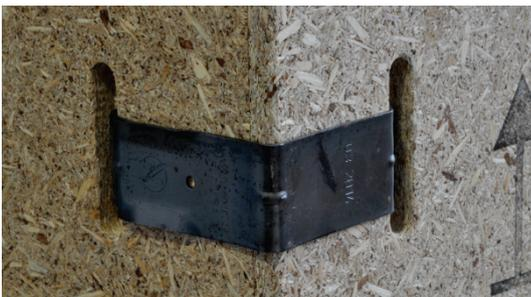
Die Einzelteile werden mit Klammerwinkeln miteinander verbunden, die in die Aussparungen an den Kanten der Seitenteile gedrückt werden.
