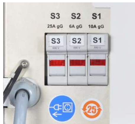
Abb. 33 Gerätesicherungen
